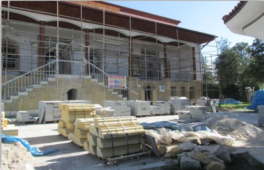
Merkez Hıdırlık Camii Ve Kerebi Gazi Türbesi Onarım İşi
